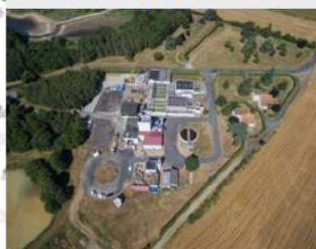
Barrage du Cébron (79) : Achat d'Eau SVL
