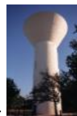
Réservoir de St Aubin du Plain :
